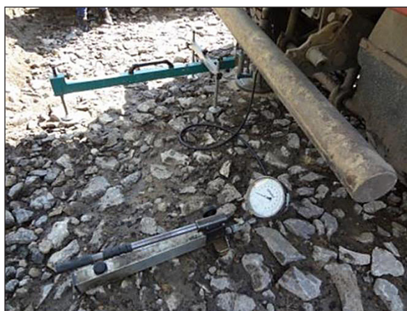
Rys. 4. Badanie nośności warstwy kruszywa grubego Fig. 4. Testing of the capacity of the coarse
