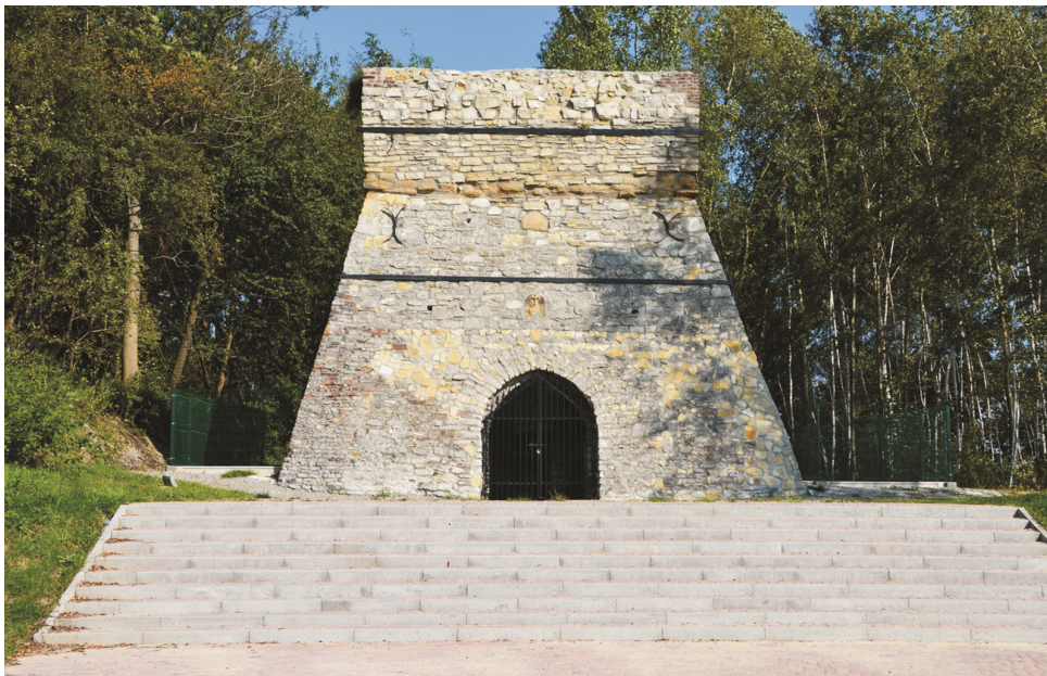
Fot. 6. Piec do wypalania wapna po odrestaurowaniu.
