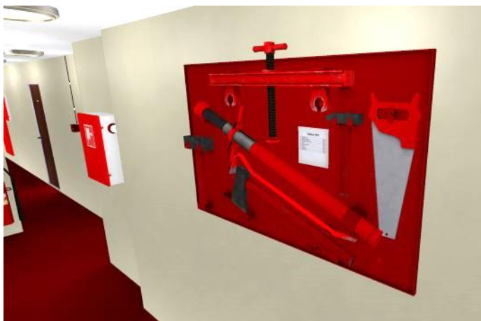
Rys. 5. Tablica OPA na ścianie. Źródło: Archiwum foto Autocomp Management Sp. z o.o.
