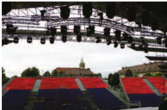
Rys. 1. Budowa tymczasowego amfiteatru opolskiego na potrzeby 47. KFPP, a) scena, b) widok ze sceny na trybuny
