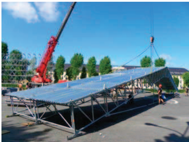
Rys. 2. Montaż dachu tymczasowej sceny amfiteatralnej na terenie parkingu, w tle budynki dawnej jednostki wojskowej
