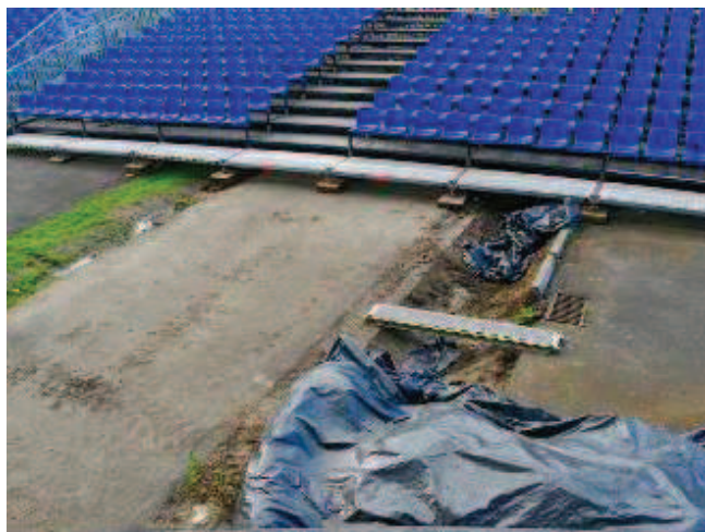
Rys. 7. Wyrównanie podłoża między sceną a trybunami za pomocą tłucznia grysowego
