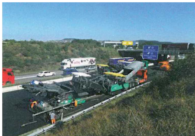
Fot. 4. Wbudowanie warstwy ścieralnej z asfaltu porowatego
