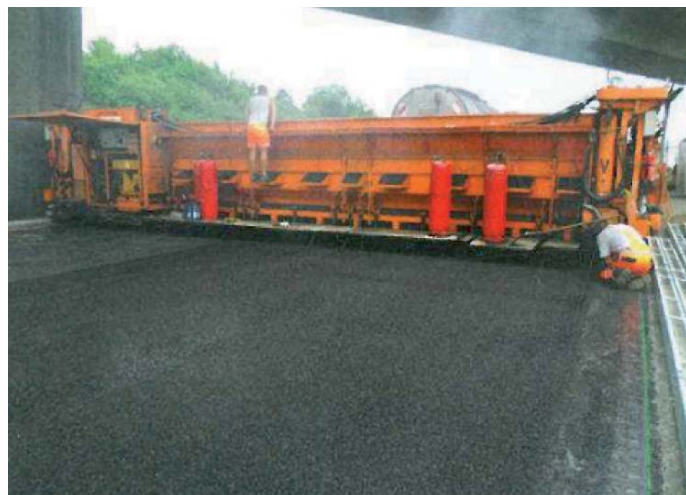
Fot. 2. Wbudowywanie asfaltu lanego jako warstwy ochronnej na obszarze remontu nawierzchni
