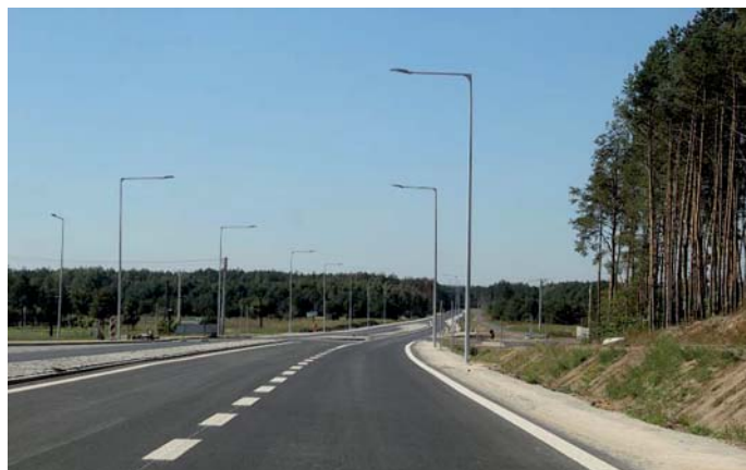
Fot. 3. Rozbudowa DW 762
