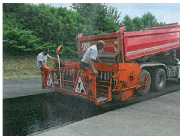
Fot. 5. Warstwa SAMI układana na sfrezowanym podłożu (zrezygnowano z modyfikowanego asfaltu gumą)
