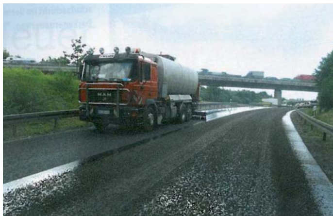
Fot. 3. Uszczelnienie podłoża warstwą SAMI
