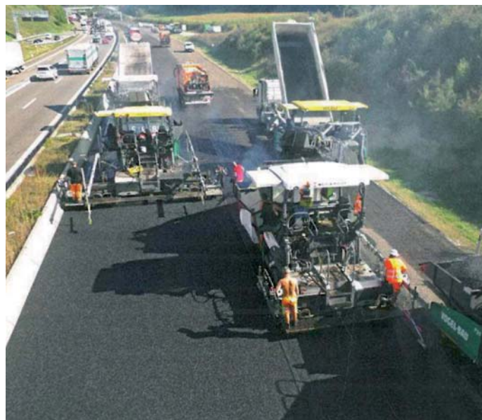
Fot. 1. Warstwa ścieralna z asfaltu porowatego wbudowywana pełną szerokością nawierzchni przy użyciu trzech rozkładarek oraz dwóch podajników pośrednich
