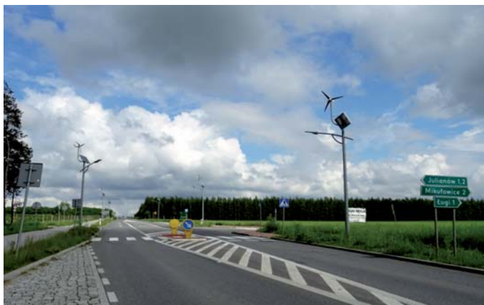
Fot. 2. Rozbudowa DW 755
