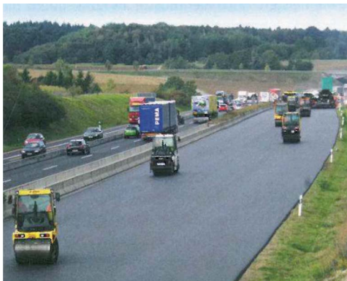
Fot. 6. Użycie 8 walców na omawianej budowie – cel odpowiednie zagęszczenie warstwy i uzyskanie dobrej równości
