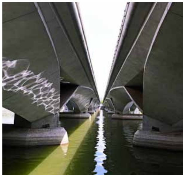
Most Esplanade Bridge. Widok wnętrza obiektu, fot. K. Ryż
