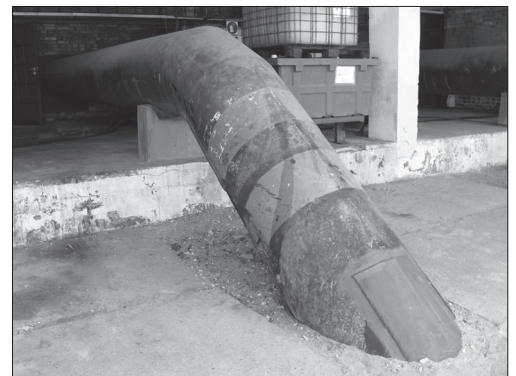
Rys. 4. Sztywne zamocowanie rury wylotowej pompy
