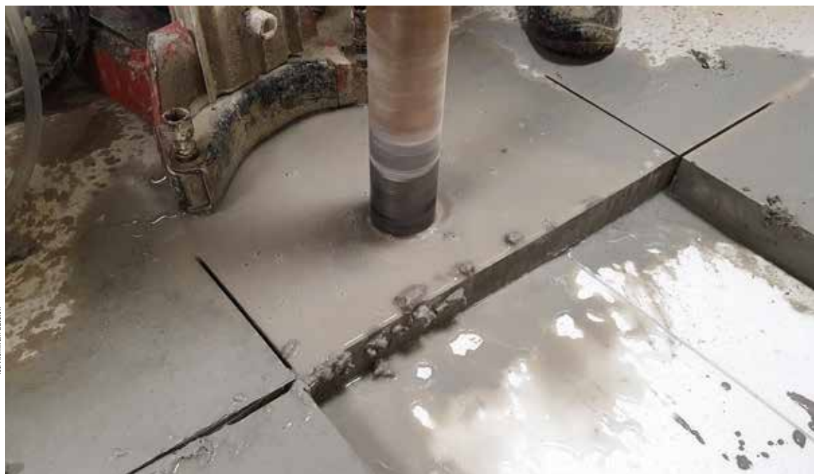
Odwiert rdzeniowy w podkładzie cementowym
