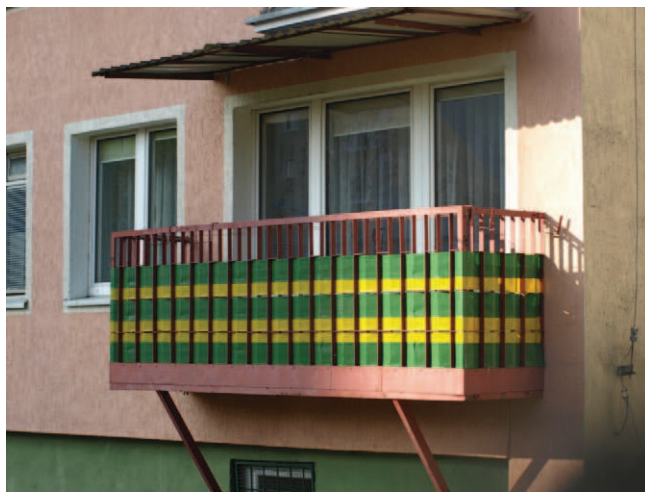
Rys. 20. Zakłócenie harmonii elewacji oraz, mimo starań, nieestetyczne wykonanie (widoczny efekt braku rozwiązania problemu dla całej elewacji) – budownictwo systemowe OWT-67. Osiedle Kormoran w Olsztynie (foto archiwum autora)
