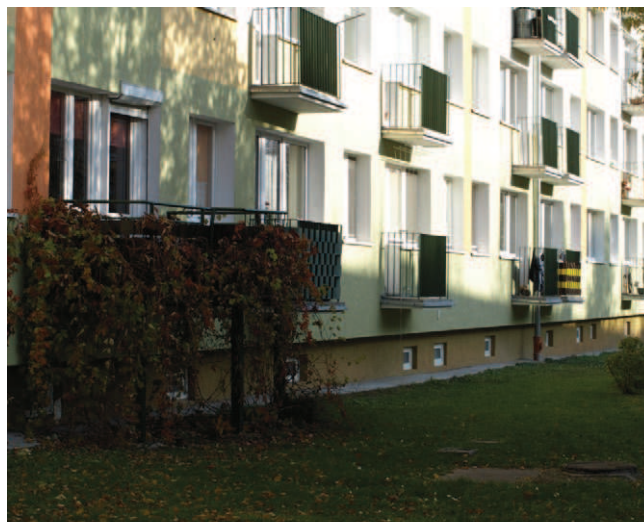
Rys. 21. Sytuacja adekwatna do powyższej (rys. 20) – budownictwo systemowe OWT-67. Osiedle Kormoran w Olsztynie (foto archiwum autora)
