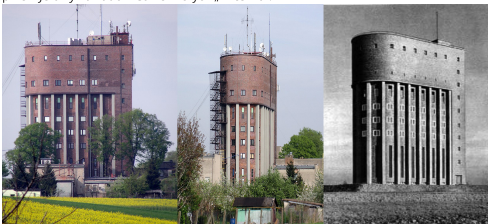
Il. 31-33. Grenzlandturm – wieża ciśnień przy ul. Starowiejskiej.
