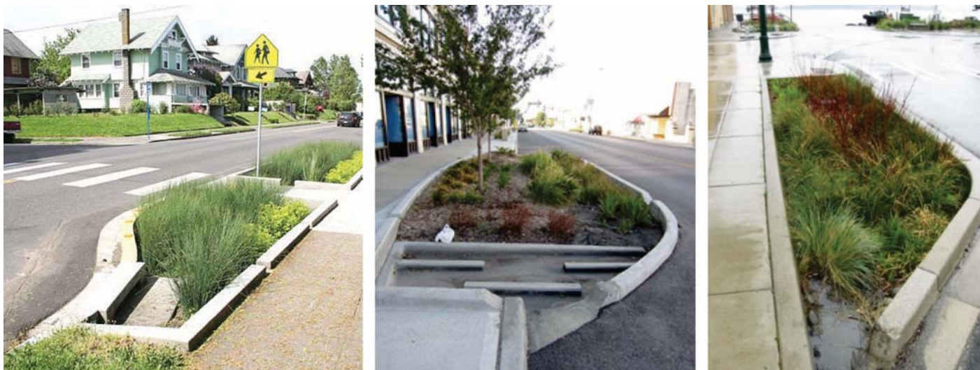
Fot. 6. Wypustki uliczne – przykłady, z prawej obszar bioretencyjny między krawężnikami podczas deszczu [20], [39]
