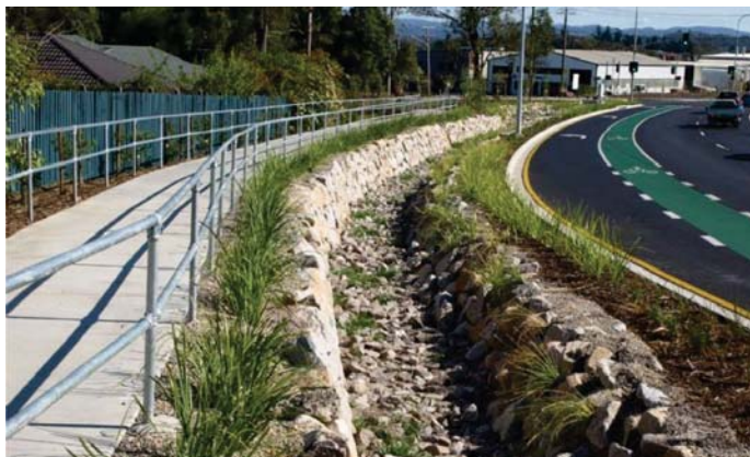
Fot. 1. Kamienny rów infiltracyjny wzdłuż trasy komunikacyjnej [36]
