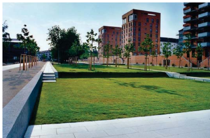
Fot. 12. Fragment parku będący na co dzień suchym zbiornikiem, zapełniającym się wodą podczas intensywnych opadów deszczu [29]
