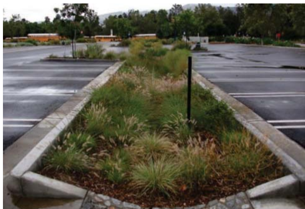
Fot. 5. Bioretencyjne wyspy środkowe na terenie parkingu, Atascadero, USA [23]
