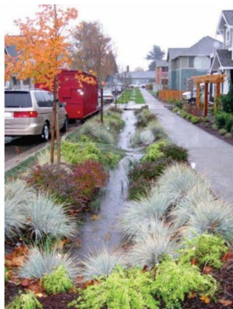
Fot. 2. Z lewej – Rów chłonny wzdłuż parkingu, proj. L. Capouya Landscape Architecture [32]; w środku – Rów trawiasty, Augustenborg, Malmö, Szwecja, fot. A. Vaxelaire [37]; z prawej – Przykład dekoracyjnego rowu wegetacyjnego w dzielnicy domów jednorodzinnych, proj. NACTO [33]
