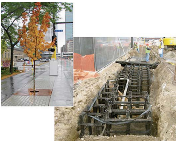
Fot. 9. Zadrzewiona mulda pod chodnikiem w centrum miasta – budowa [25]
