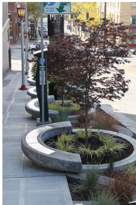
Fot. 10. Mulda retencyjno-infiltracyjna w kształcie kaskad, Maynard w Seattle (Waszyngton, USA) [35]
