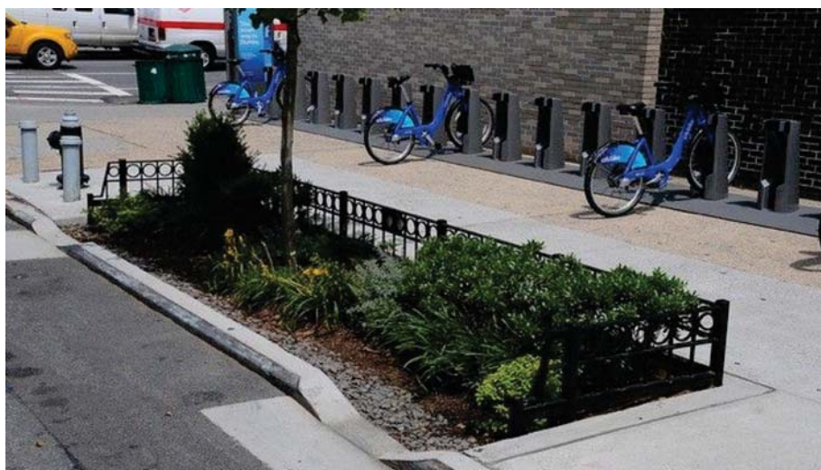
Fot. 8. Jeden z wielu boksów roślinnych zainstalowanych wzdłuż ulic Nowego Jorku, które rozładują ogromny spływ wód do kanalizacji burzowej [31]
