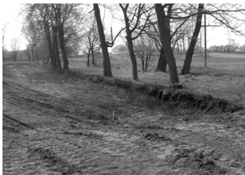
Fot. 3. Budowa boiska w pobliżu ostatnich ocalałych grabów historycznego szpaleru w parku w Lednogórze. Photo 3. A sports field being built in the vicinity of the last remaining hornbeams of the historical avenues in the Lednogóra park.
