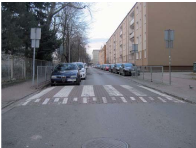
Fot. 2. Widok ogólny liniowego progu zwalniającego płytowego o zmniejszonej szerokości (skróconego)
