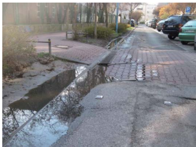
Fot. 8. Uszkodzenia rusztu (brak śrub) i skutek zamulenia wlotu ścieku – zastoisko wodne sprzyjające uszkodzeniu konstrukcji nawierzchni progu i drogi
