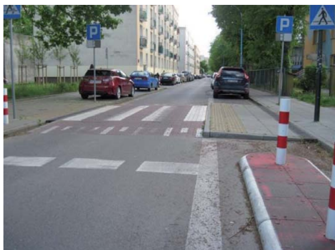
Fot. 5. Liniowy próg zwalniający płytowy z obustronnymi ściekami płaskimi przekrytymi rusztami
