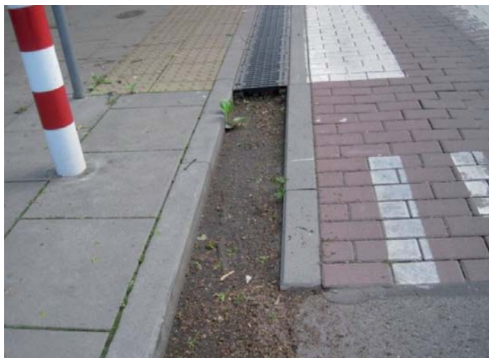
Fot. 6. Zamulenie i zanieczyszczenie na wlocie po obu stronach progu – latem i jesienią
