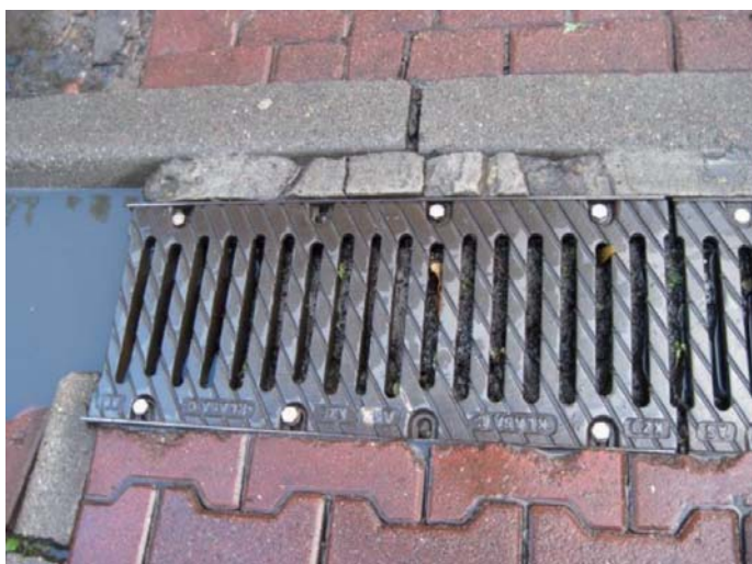
Fot. 8. Uszkodzenia rusztu (brak śrub) i skutek zamulenia wlotu ścieku – zastoisko wodne sprzyjające uszkodzeniu konstrukcji nawierzchni progu i drogi
