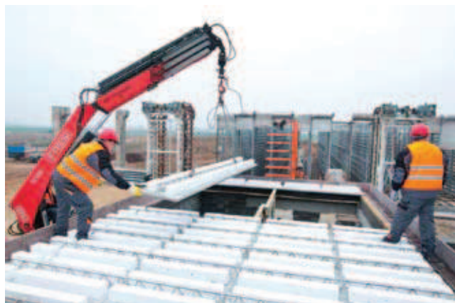
Rys. 4. Montaż gęstożebrowego stropu zespolonego Vector 60/20s (z kształtkami styropianowymi); źródło: archiwum firmy Konbet Poznań
