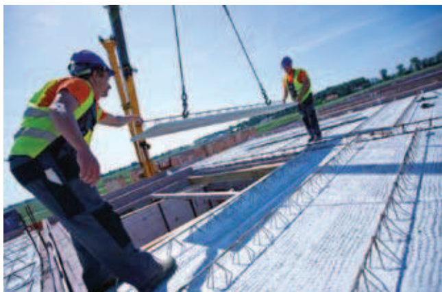
Rys. 3. Montaż gęstożebrowego stropu zespolonego Vector 60/20 (źródło: archiwum firmy Konbet Poznań)
