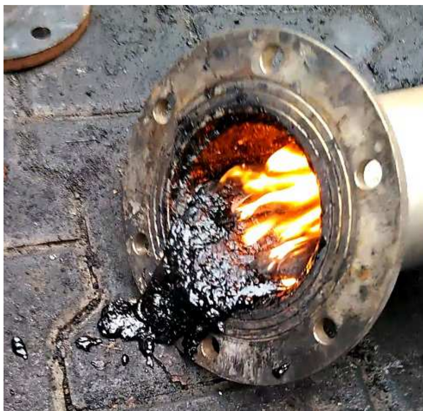
Rys. 1: Oczyszczanie chłodnicy gazu generatorowego z instalacji do zgazowania biomasy w małej skali przez wytapianie smoły
