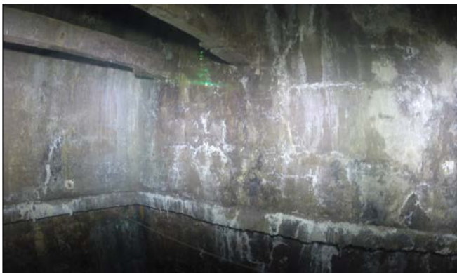
Fot. 4. Stan wschodniej i południowej części obudowy szybowej na głębokości około 7,0m pod poziomem posadzki piwnicy szybowej- stan po zakończeniu I etapu robót iniekcyjnych
