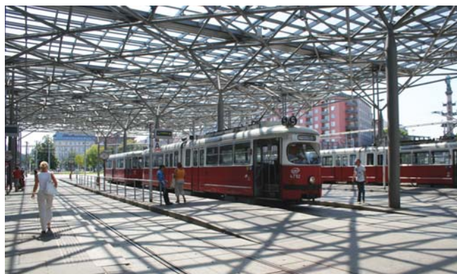
Fot. 7. Błędnie zaprojektowane zadaszenie placu dworcowego Wien Paternstern: cienie dachu i dylatacje nawierzchni zamazują krawędzie jezdni, krawężników, torów tramwajowych i oznaczeń dla niewidomych. Fot. D. Załuski
