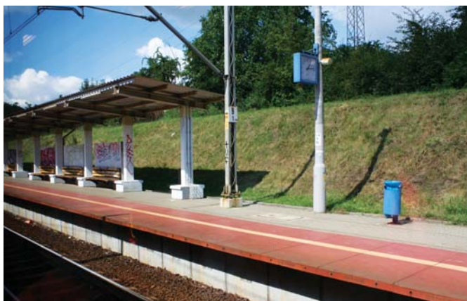
Fot. 6. Substandardowy przystanek Warszawa Rakowiec na linii SKM Warszawa Lotnisko Chopina – Warszawa Zachodnia, oddanej do użytku w 2012 r. Fot. D. Załuski
