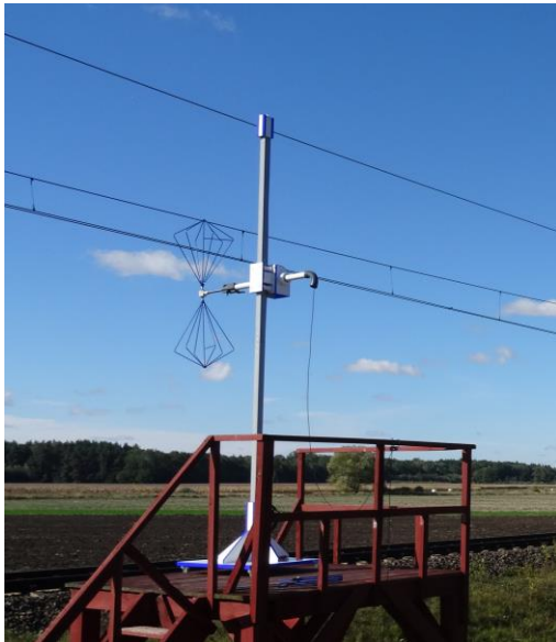
Rys.6. Antena dwustożkowa z masztem podczas pomiar emisji zaburzeń postronnych środowiska elektromagnetycznego (Tlo)
