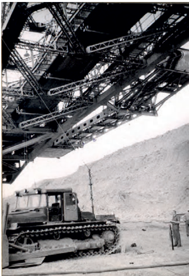
Rys. 7. Układ obciążający wysięgnik przy pomiarze sztywności [2] Fig. 7. Loading arrangement for measuring the stiffness the boom [2]
