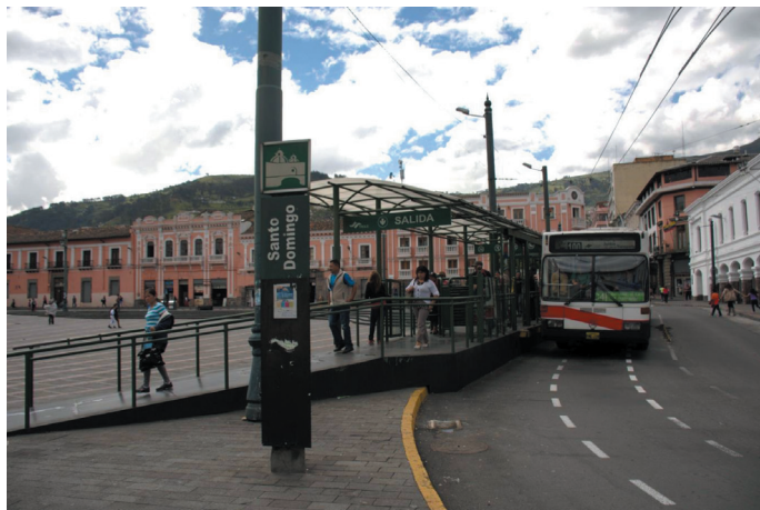
Fot. 3. Przystanek dla trolejbusów BRT (linia Trole) w centralnej części Quito wyposażony jest w zadaszenie, pochylnie, bramki na wejściu i ruchome drzwi otwierane dopiero w momencie podjechania pojazdu. Posiada również unikalne oznaczenie graficzne umożliwiające łatwą jego identyfikację. Autor: Joanna Gadzińska
