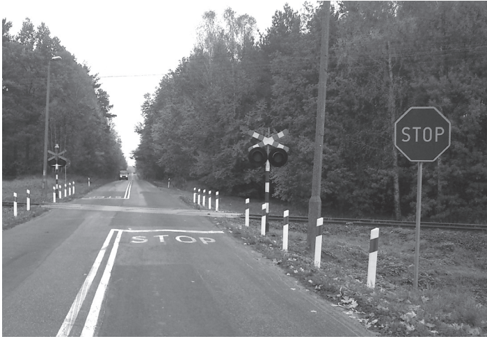
Rys. 1. Widok przejazdu kategorii C w km 5,689 na linii nr 211 [fot. M. Szopinski]
