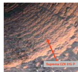
Ryc. 3. Obszar testowy na płaszczu pieca obrotowego
