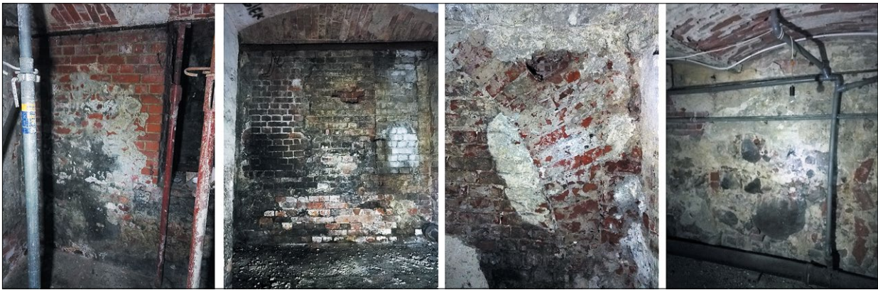
Ryc. 9. Ściana frontowa: a) elementy III fazy budowlanej; b) fragment ściany frontowej. Widoczne elementy III i IV fazy budowlanej; c) łuk odciążający z II fazy budowlanej; d) fragment muru granicznego z II fazy budowlanej.
