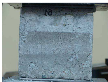
Rys. 6. Widok próby ściskania skorodowanej kostki betonowej
