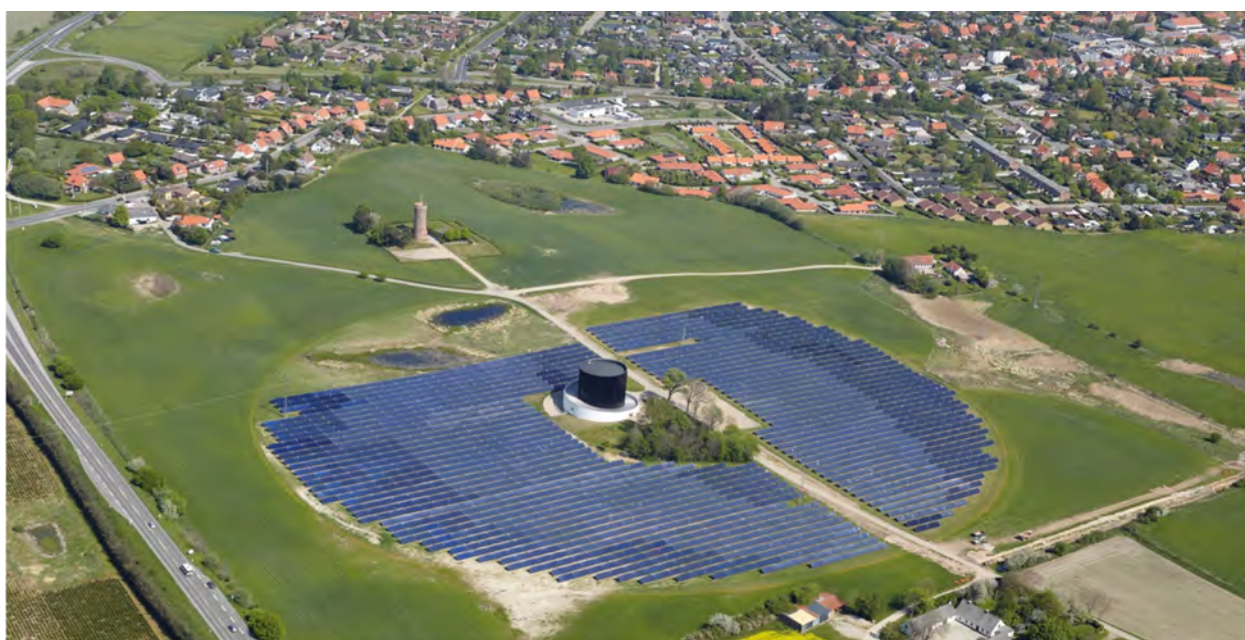
Rys. 2. Solarna wyspa ciepła wraz z akumulatorem ciepła Źródło: Arcon Sunmark, Forum Energii*
