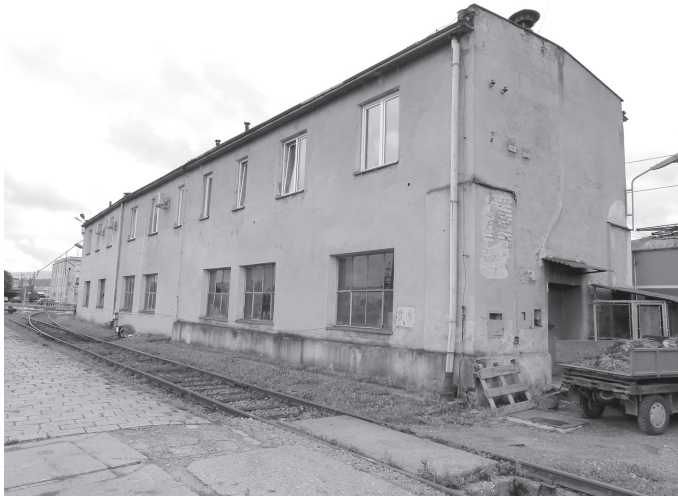
Fot. 7. Budynek Oddziału Urzędzeń Technicznych 35
