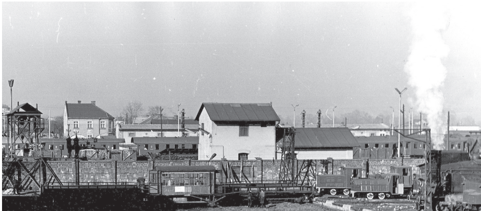
Fot. 4. Parowozownia w 1969 roku 32
