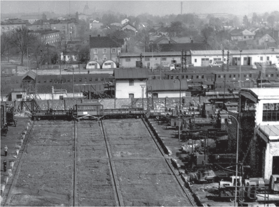
Fot. 6. Budynek dawnej stacji ropałowej w 1970 34
