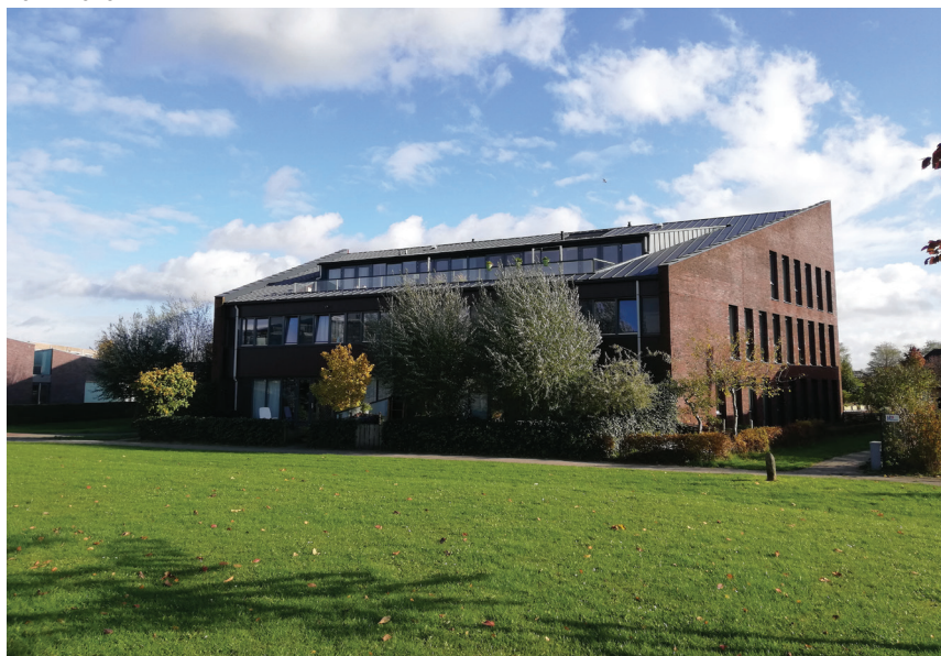
Rys. 8. Budynek w ramach projektu Talita od strony tylnej, autor: Agnieszka Labus, 10.11.2019
