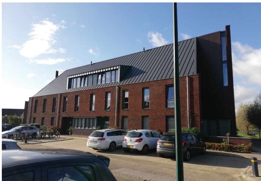
Rys. 7. Budynek w ramach projektu Talita od strony wejścia głównego, autor: Agnieszka Labus, 10.11.2019
