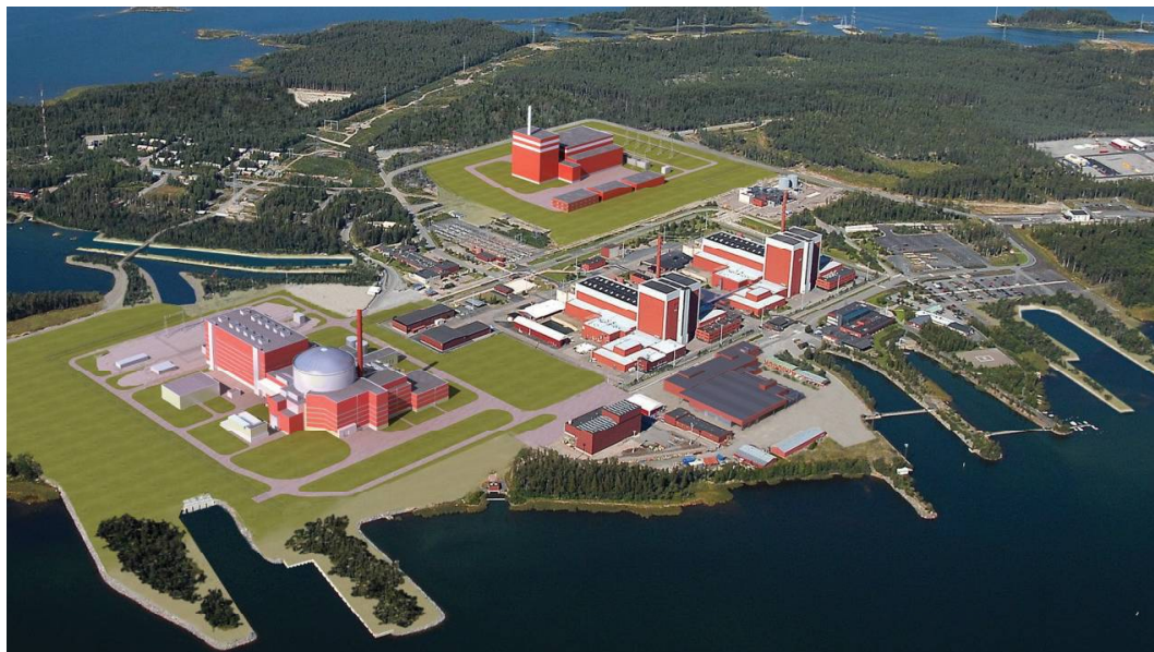
Fot. 5. EJ Olkiluoto z obecnie pracującymi blokami nr 1 i 2, budowanym blokiem nr 3 oraz planowanym blokiem nr 4, wizja artystyczna (fot. TVO) Photo 5. Olkiluoto NPP with currently operating Units 1 and 2, Unit 3 under construction and planned Unit 4, artistic impression (fot. TVO)
