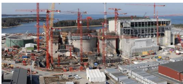
Fot. 2. Budowa bloku nr 3 w EJ Olkiluoto, kwiecień 2008 r. (fot. TVO) Photo 2. Construction of unit 3 in Olkiluoto NPP, April 2008 (photo: TVO)
