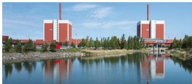
Fot. 1. EJ Olkiluoto z dwoma blokami jądrowymi typu BWR (fot. TVO/Hannu Huovila)
