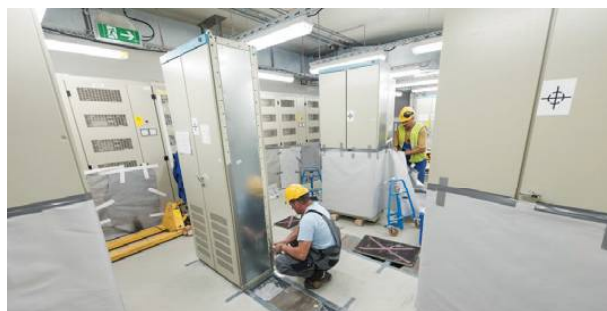
Fot. 3. Montaż przeprojektowanej aparatury kontrolno-pomiarowej i automatyki (AKPiA) w bloku nr 3, zatwierdzonej przez STUK (fot. TVO) Photo 3. Installation works of redesigned I&C in Olkiluoto Unit 3, approved by STUK (photo: TVO)
