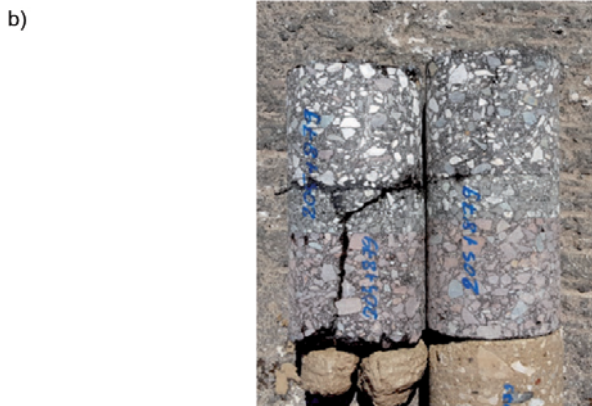
Rys. 9. Obserwowane niekiedy w nawierzchniach podatnych i półsztywnych pęknięcia asymetryczne, a) schemat, b) przykład pęknięć skośnych i przesuniętych
