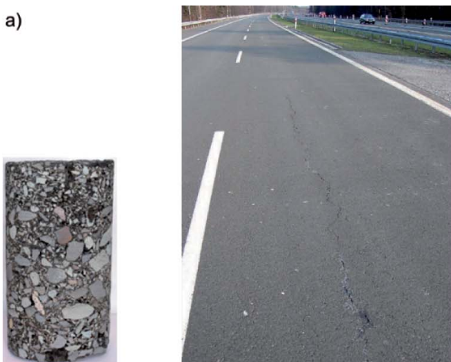
Fot. 2. Przykłady pęknięć pojedynczych: a) „z góry na dół”, b) źródło pęknięć odbitych (fot. TPA)
