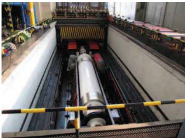
Fot. 22. Wyważarka wirników turbogeneratorów – Alstom Power [4]
