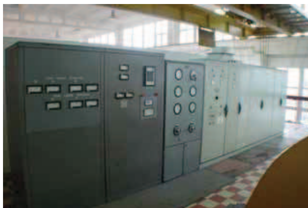
Fot. 20. Układ sterowania sprężarki TK-16 w KWK „Borynia” [4]
