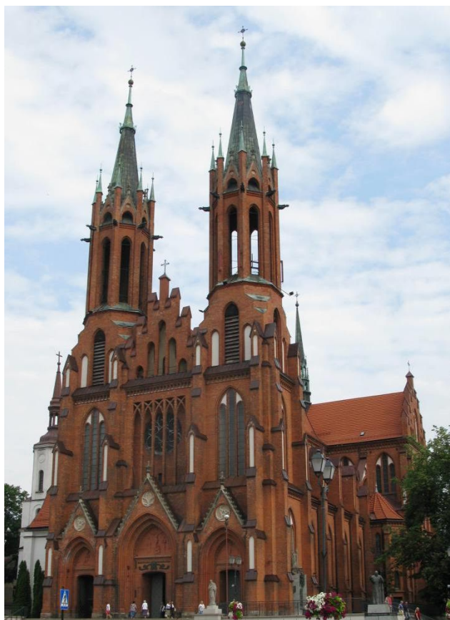
Rys. 1. Elewacja frontowa budynku kościoła
