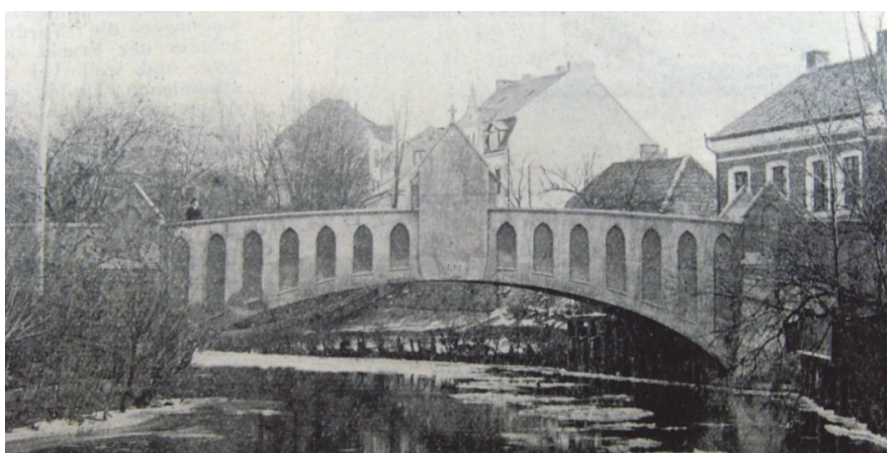
Rys. 1. Widok na przęsło od strony zachodniej, rok 1909 [1]
