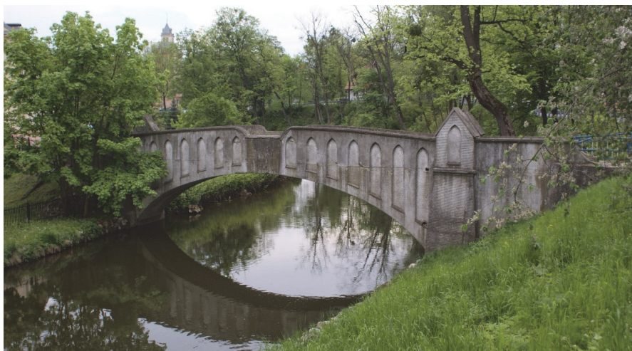
Rys. 3. Widok z boku od strony górnej wody
