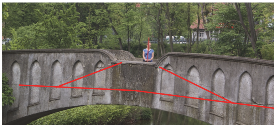
Rys. 7. Schemat zarysowania ścian bocznych konstrukcji
