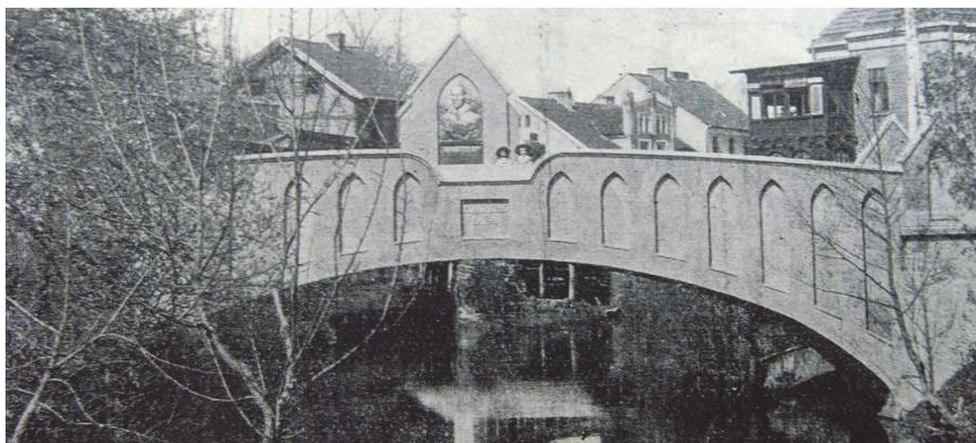
Rys. 2. Widok na przęsło od strony wschodniej, około roku 1920 [1]
