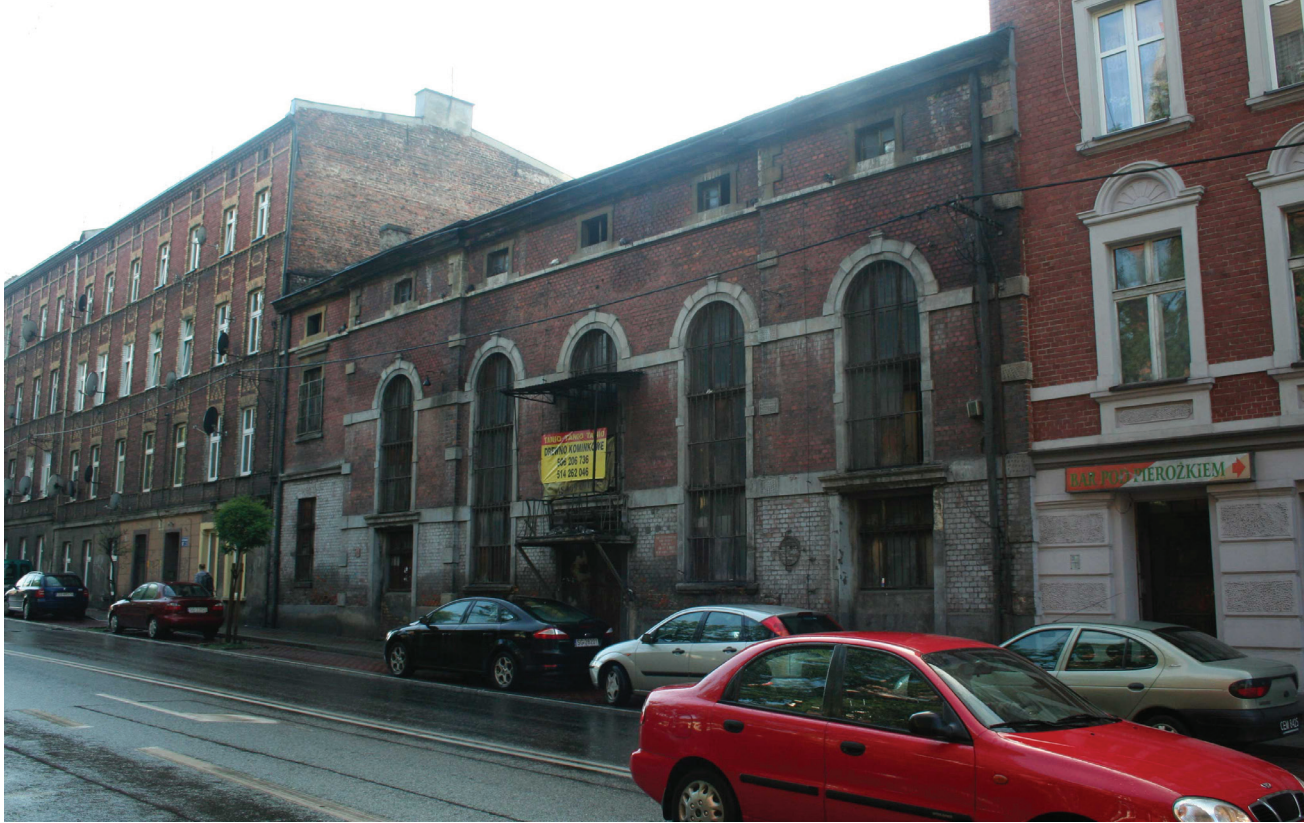
Rys. 15. Budynek dawnej sali tanecznej, później magazyn przy ul. Styczyńskiego 59 w Gliwicach. Stan w roku 2012 (fot. A. Grzybowski)
