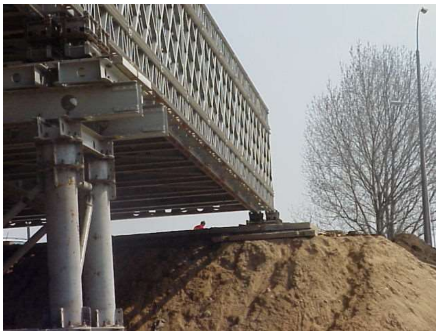
Rys. 1.3. Podparcie na przyczółku wykonane z płyt betonowych
