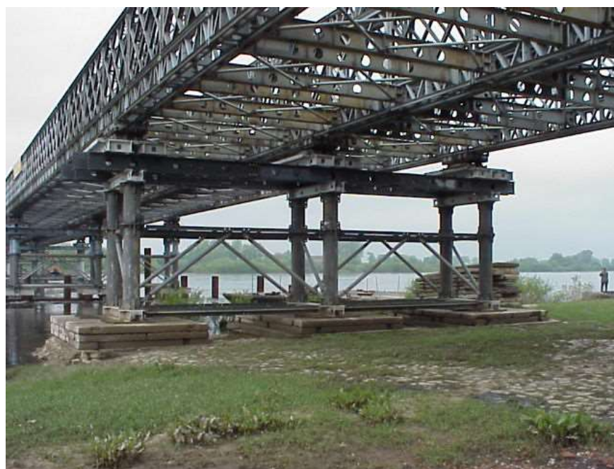
Rys. 1.4. Podpora pośrednia na płytach żelbetowych
