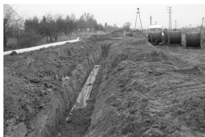
Rys. 8. Linia kablowa SN w budowie
