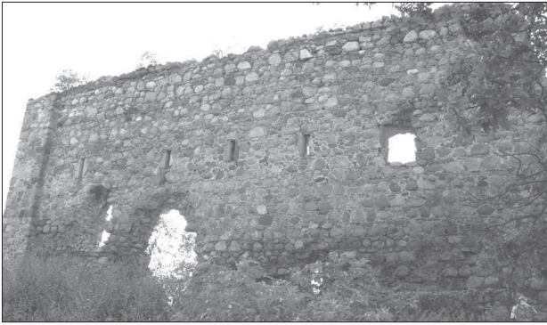
4. Papowo Biskupie. Widok elewacji skrzydła wschodniego zamku, fot. M. Wiewióra
