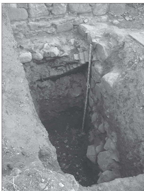
11. Papowo Biskupie. Skrzydło południowe zamku. Widok fragmenty piwnicy i reliktyw sklepienia, fot. M. Wiewióra 11. Papowo Biskupie. The southern wing of the castle. View of the cellar and vault relicts, photo: M. Wiewióra
