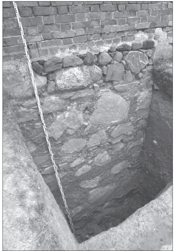
18. Radzyń Chełmiński. Skrzydło zachodnie zamku. Widok lica fundamentu muru zachodniego skrzydła zachodniego zamku, fot. M. Wiewióra
