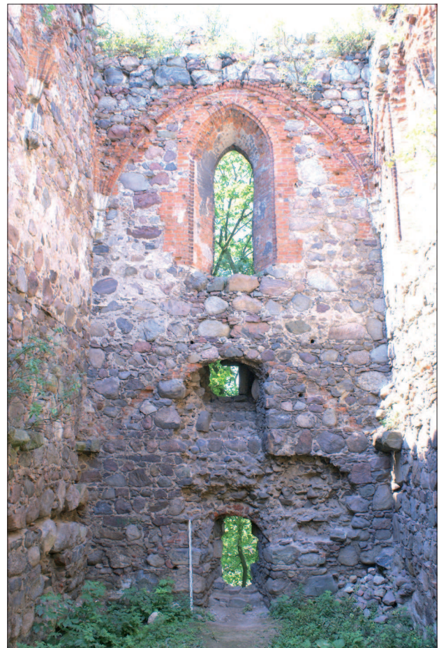
8. Papowo Biskupie. Skrzydło północne zamku. Kapitularz. Widok okna w ścianie zachodniej, fot. M. Wiewióra
