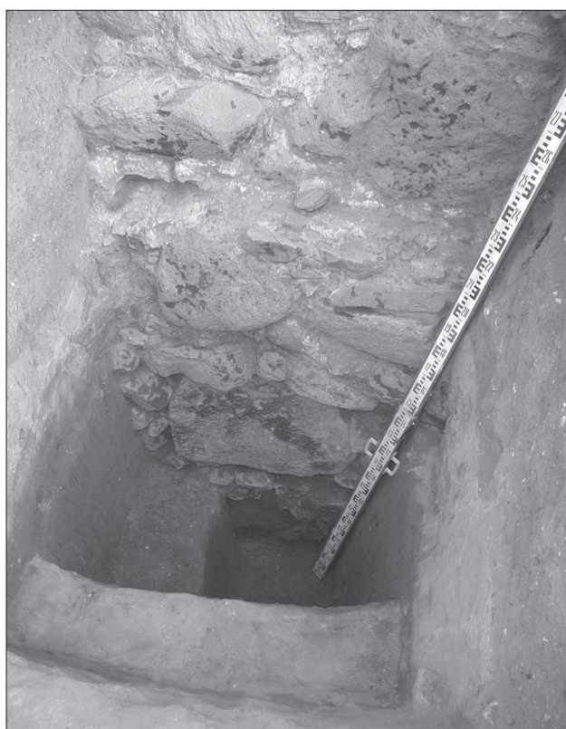
10. Papowo Biskupie. Skrzydło południowe zamku. Lico ściany fundamentu, fot. M. Wiewióra 10. Papowo Biskupie. The southern wing of the castle. The outer face of the foundation wall, photo: M. Wiewióra
