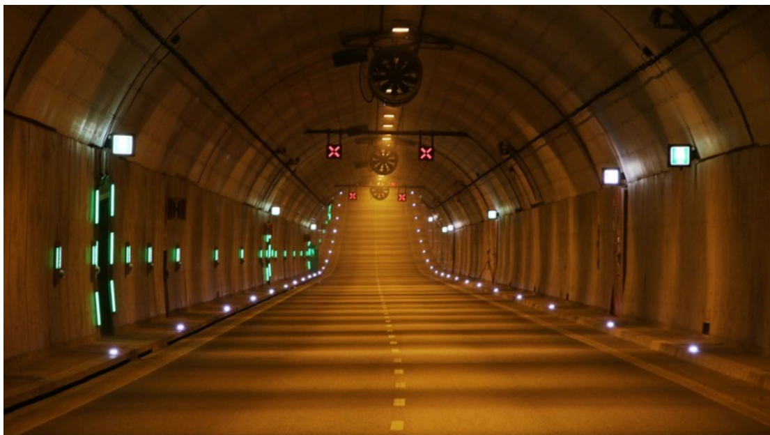
Rys. 15.6 Tunel pod Martwą Wisłą w Gdańsku
