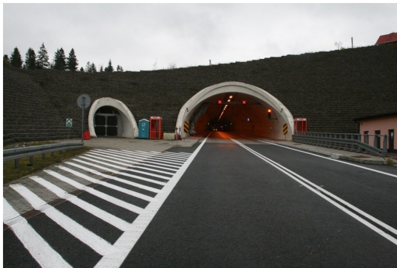
Rys. 15.1 Wjazd do tunelu Laliki od południa
