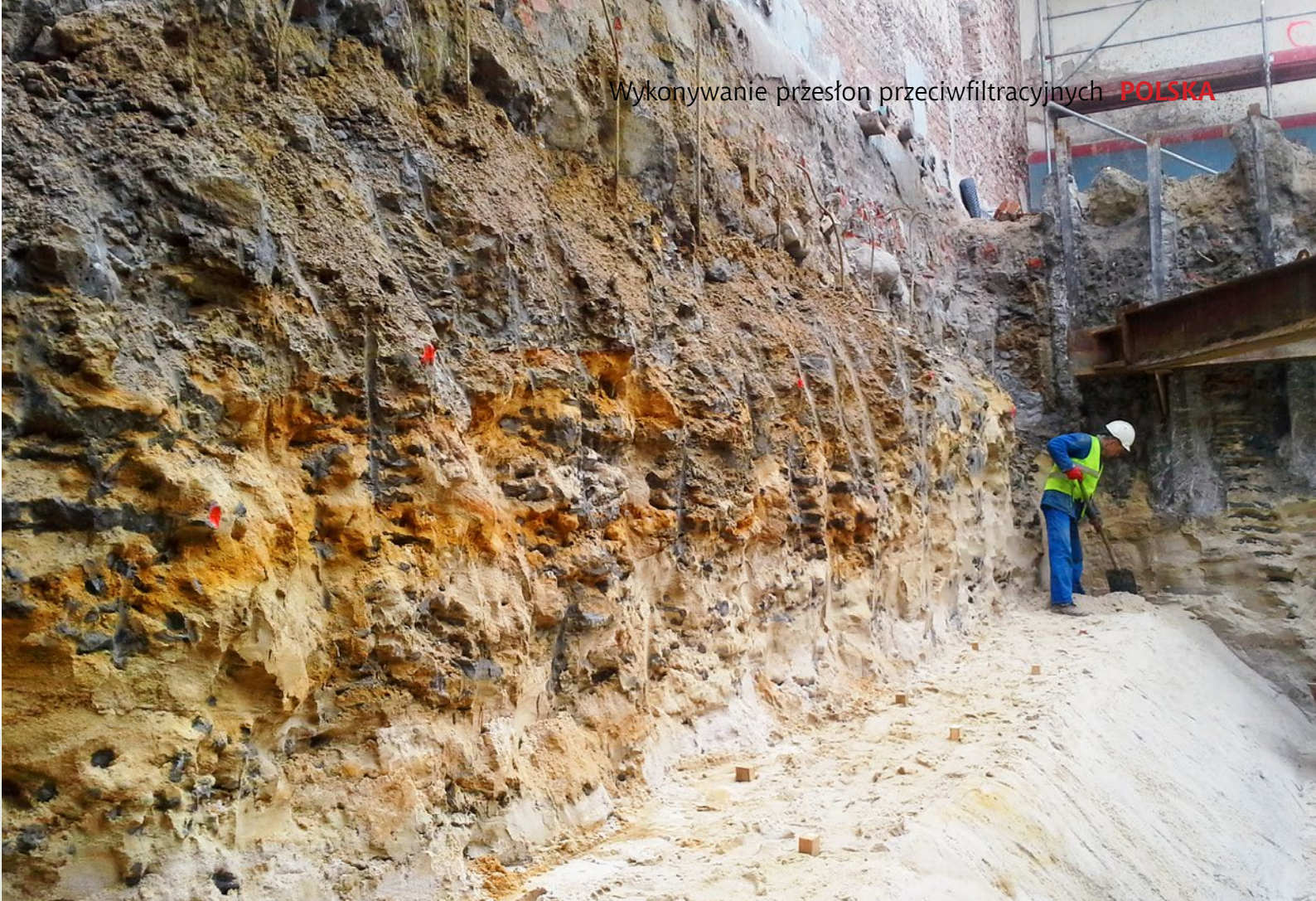
Przesłona przeciwfiltracyjna typu jet grouting
