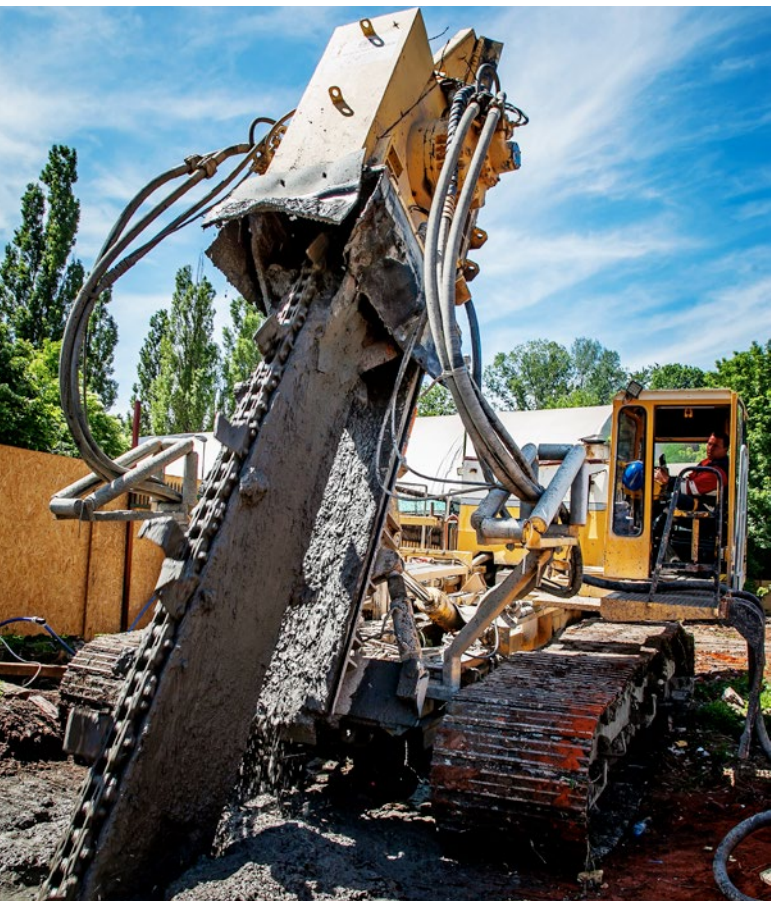
Wykonywanie przesłony przeciwfiltracyjnej w technologii TRENCHMIX®
