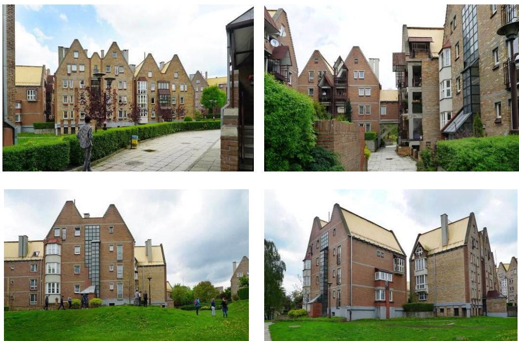
Fig. 8. In spite of typing ... – Mikołów, a housing complex "Nad Jamną". /photo author/ Ryc. 8. Na przekór typizacji... – Mikołów, zespół mieszkaniowy „Nad Jamną”. /fot. autor/
