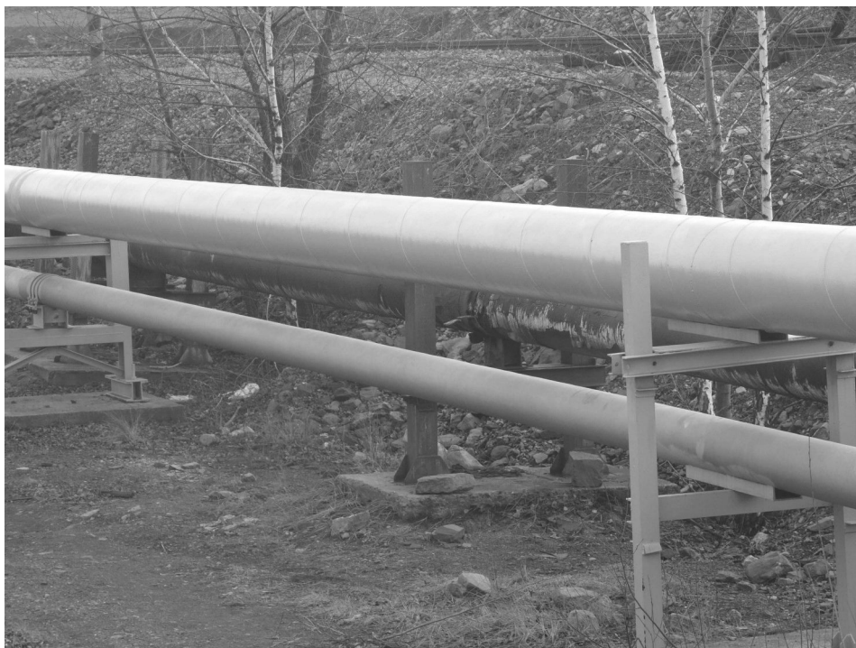
Rys. 3 Rurociąg odgazowujący i odprowadzający azot
