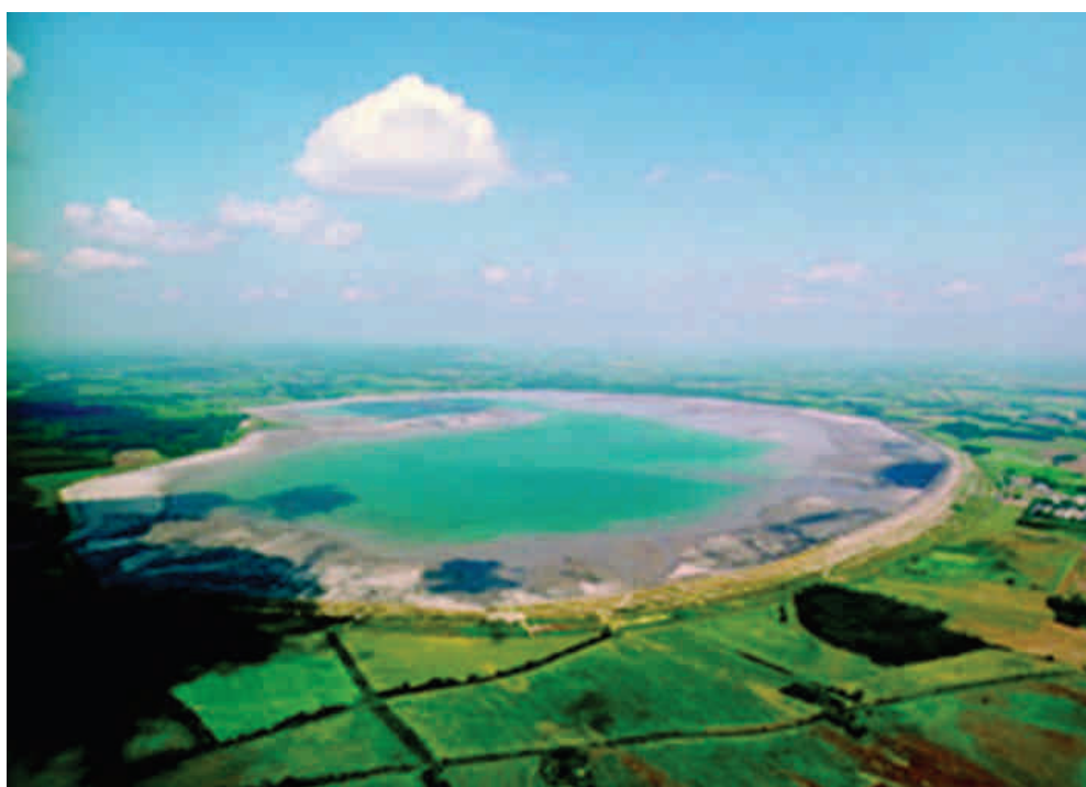
Ryc. 1. Widok na zbiornik odpadów poflotacyjnych „Żelazny Most” [8]
