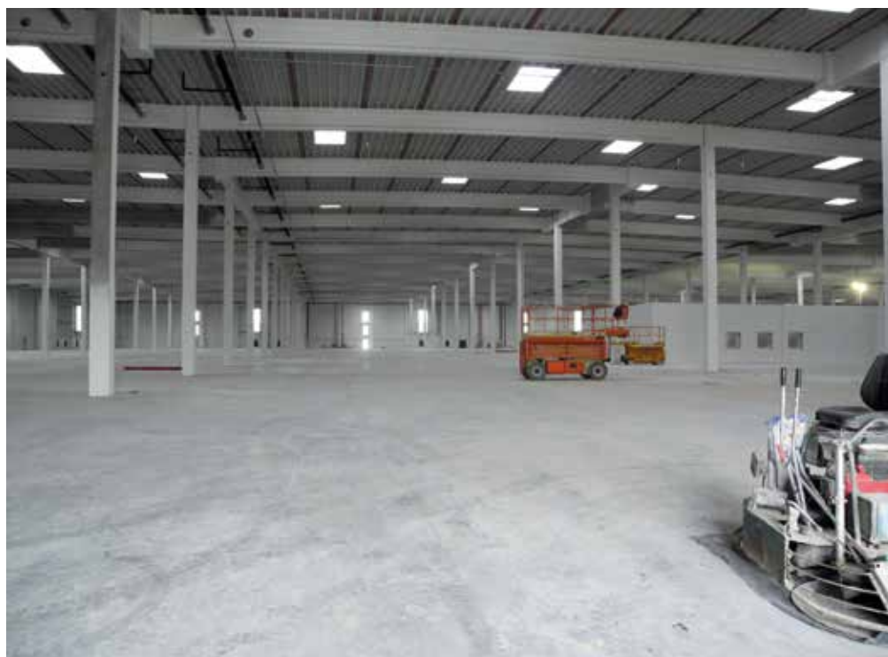
Gotowa posadzka przemysłowa z zastosowaniem domieszki MC PowerFlow 5100 (zdj. zbiór własny)
