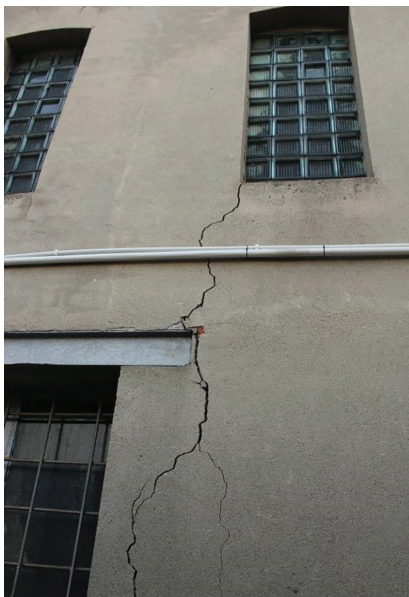
Fot. 1. Widok na elewację hali produkcyjnej od strony północno-zachodniej, 2014 r.
