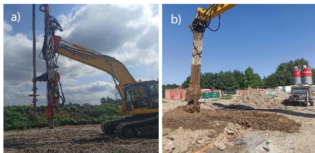
Rys. 2. Urządzenie do głębokiego mieszania podczas realizacji prac: a) z masztem SPD i padłem DSM, b) z osprzętem do stabilizacji masowej
