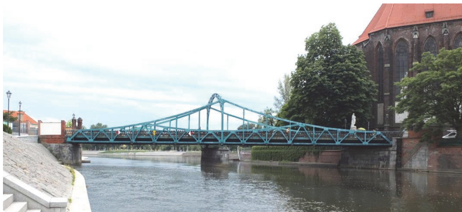
Rys. 1. Widok ogólny mostu Tumskiego
