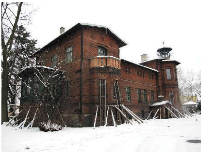
Fot. 1. Budynek Ostoi Pokoju przed rektyfikacją (Gromysz 2020)
