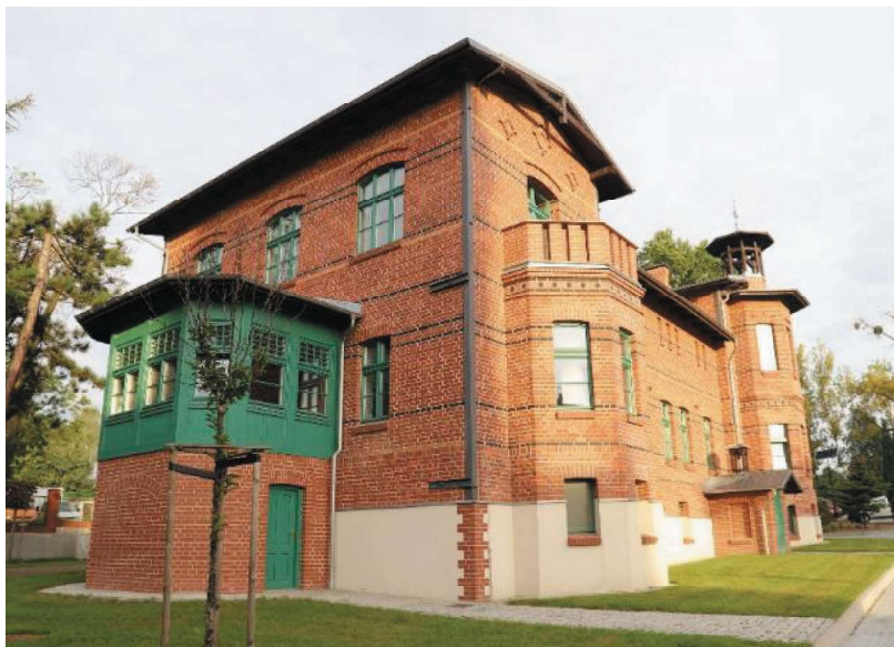
Fot. 2. Budynek Ostoi Pokoju po rektyfikacji i rewitalizacji, rok 2020 (Gromysz 2020) Photo 2. Peace Place building after rectification and restoration, 2020 (Gromysz 2020)
