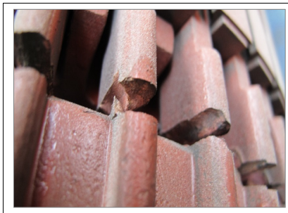
Rys. 4. Przełom uszkodzonych prętów wirnika silnika trakcyjnego
