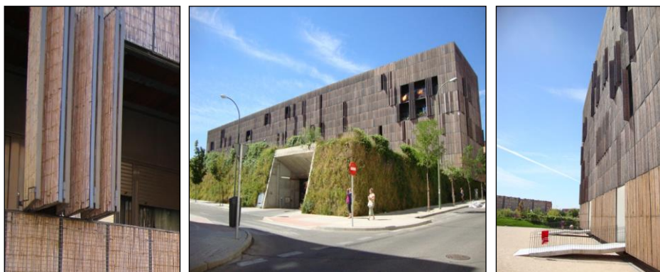
Fot. 5, 6 i 7. Zrównoważony dom społeczny Carabanchel 16 – Bambusowe żaluzje ruchome kreują architekturę elewacji budynku [Wojtyszyn 2010]
