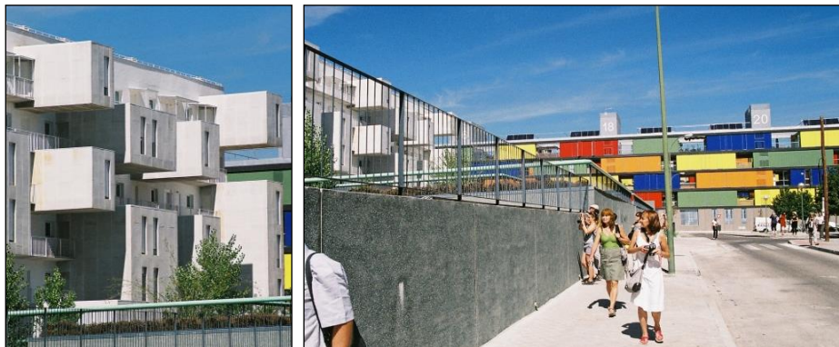
Fot. 8 i 9. Zrównoważone domy społeczne Carabanchel Carabanchel 20 i 21: C20 – głęboko urzeźbiona elewacja budynku i C21 – kolorowe poziomo przesuwne żaluzje są efektem technicznych innowacji [Wojtyszyn 2010]
