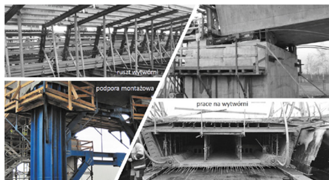
Ryc. 2. Zdjęcia z budowy metodą nasuwania podłużnego estakady Heweliusza w Gliwicach
