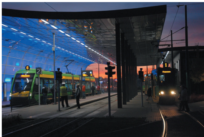
Fot. 1. Zmodernizowany dworzec autobusowo-tramwajowy na pętli Junikowo
